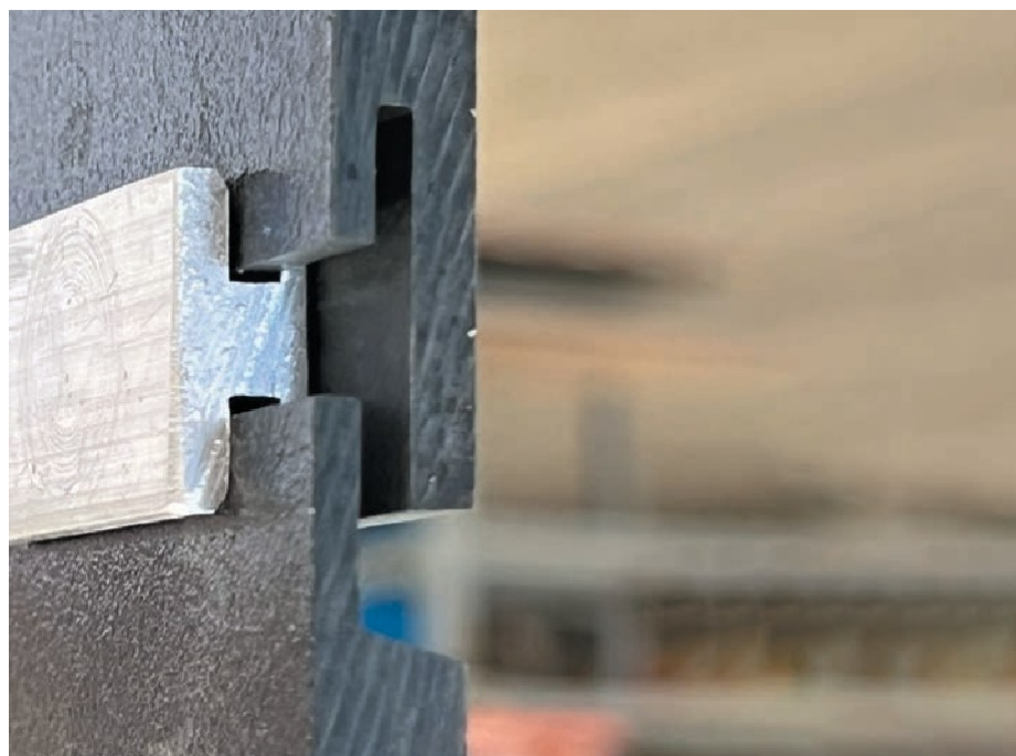
Príklad inštalácie "pero a drážka"
